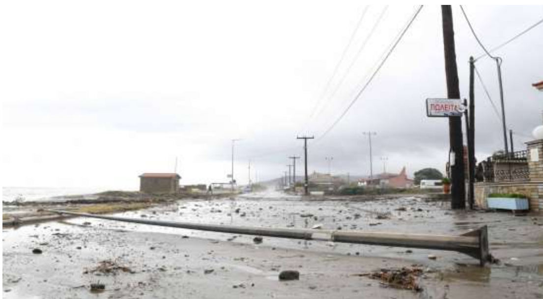
Εικόνα 1.6: Αποκατάσταση των ζημιών στο δημοτικό φωτισμό και καθαρισμός φερτών υλικών .
