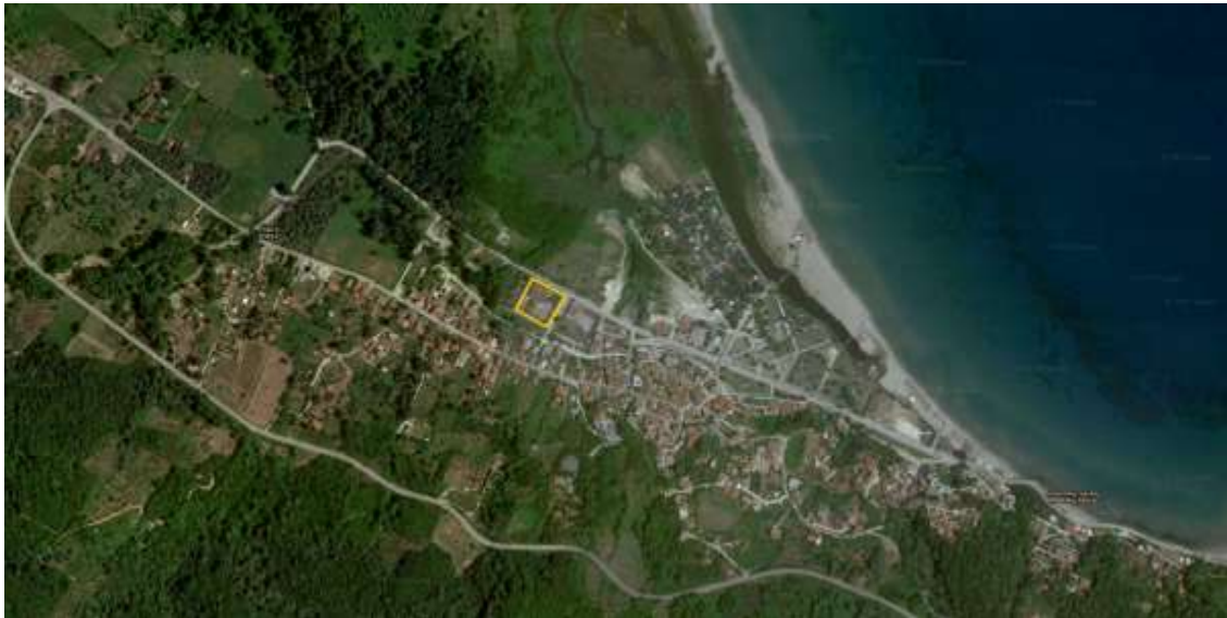
Σχήμα 2: Δημοτικό Σχολείο Στομίου_ Ως χώρος υποδοχής
