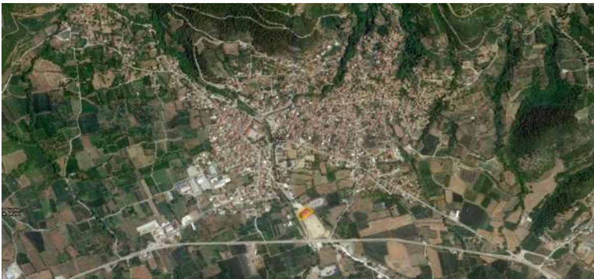
Σχήμα 2: Κλειστό Γυμναστήριο Αγίας_ Ως χώρος υποδοχής
