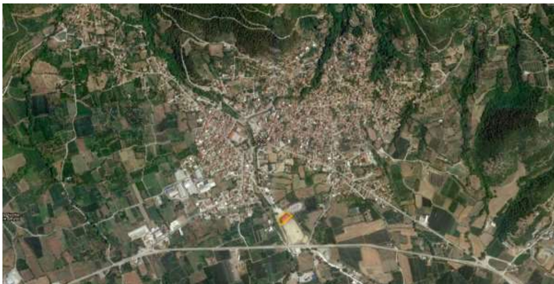
Σχήμα 3: Κλειστό Γυμναστήριο Αγιάς_ Ως χώρος υποδοχής
