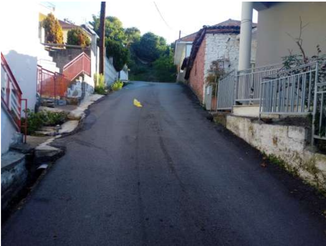
Εικόνα 6: Οδός Κανάβα στη θέση της συμβολής της με την οδό Αναλήψεως
