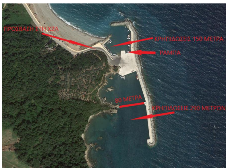
Εικόνα 1: Η λιμενική υποδομή στον Αγιόκαμπο
