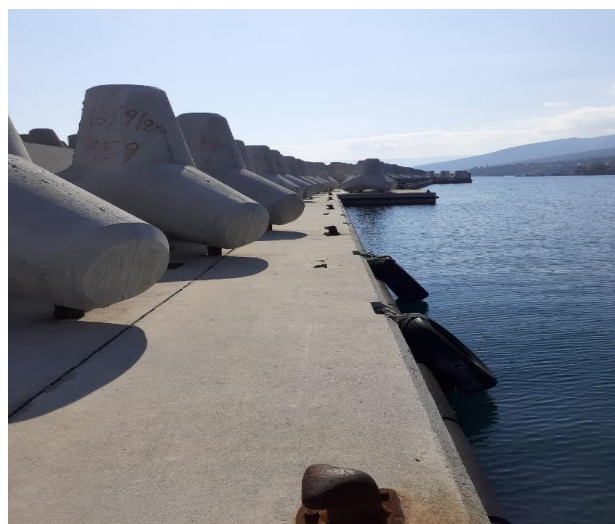
Εικόνα 4: Τεχνητοί ογκόλιθοι για την κυματική προστασία του λιμένα επί της κρηπίδωσης του προσήνεμου μόλου.
