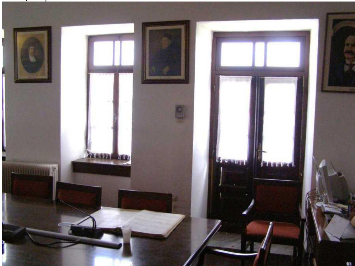
Εικόνα 5: Τυπικά ξύλινα κουφώματα κτιρίου
