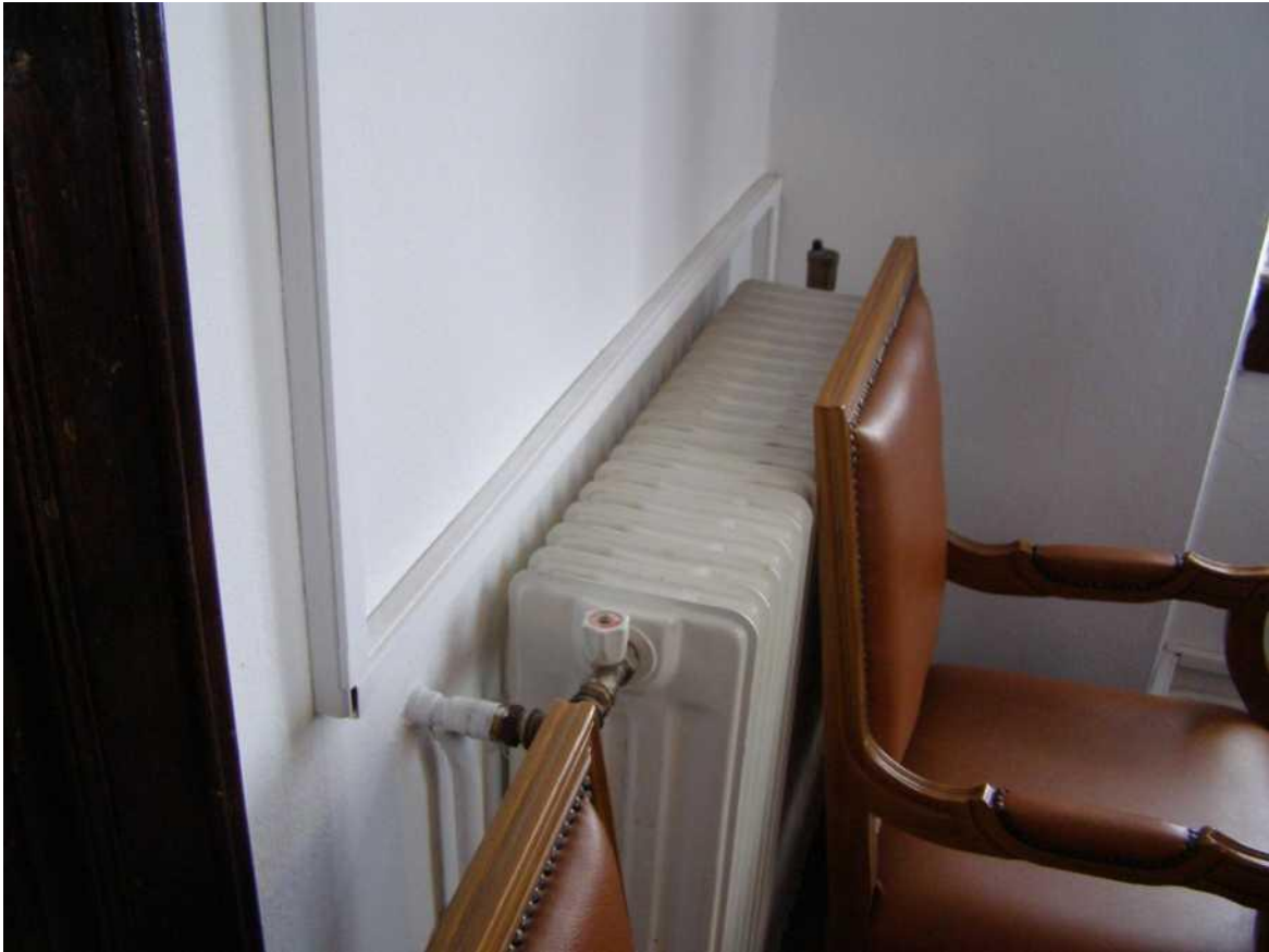
Εικόνα 9: Τοποθέτηση θερμαντικού σώματος
