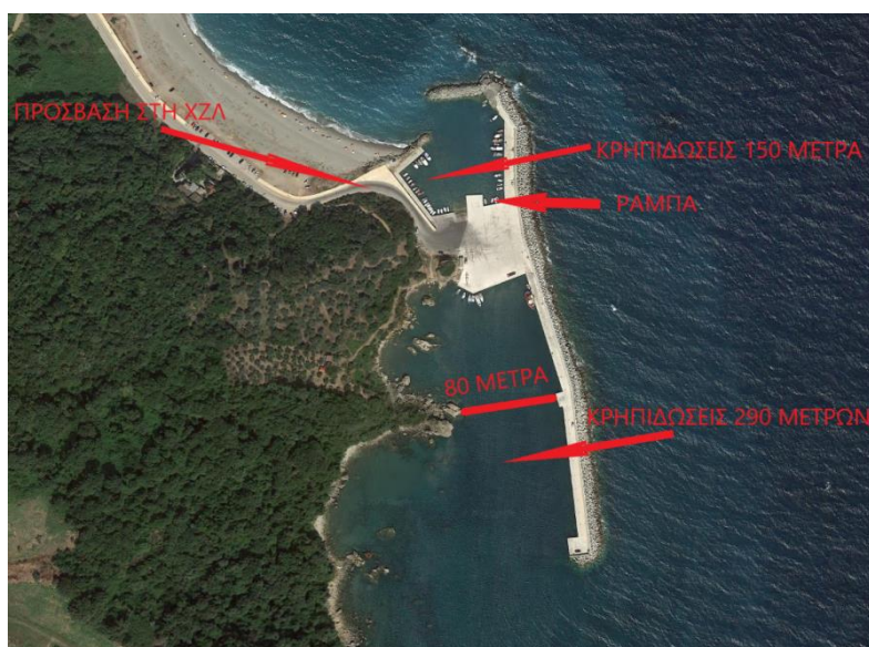
Εικόνα 1: Η λιμενική υποδομή στον Αγιόκαμπο
