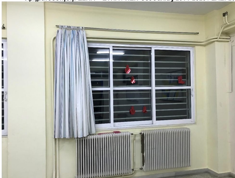
Εικόνα 8 : Τυπικό παράθυρο κτιρίου
