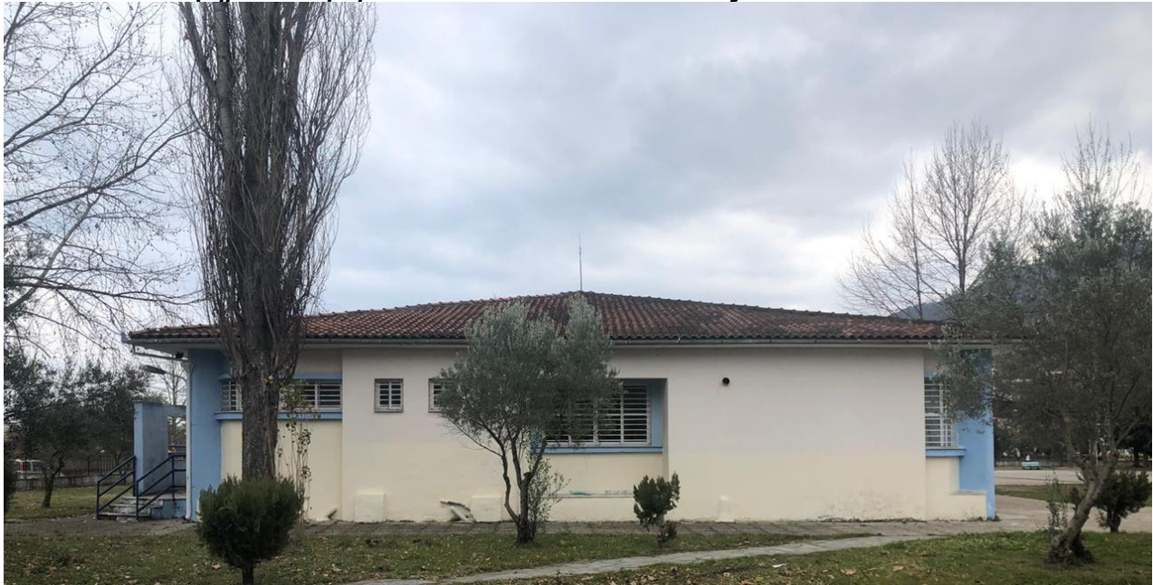
Εικόνα 4: Νοτιοανατολική όψη του κτιρίου
