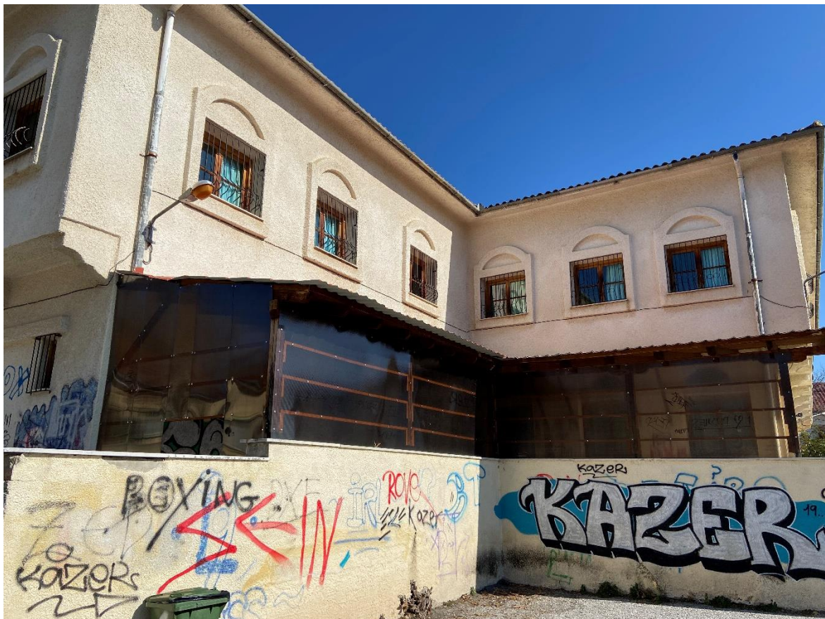
Εικόνα 4: Νοτιοδυτική όψη του κτιρίου
