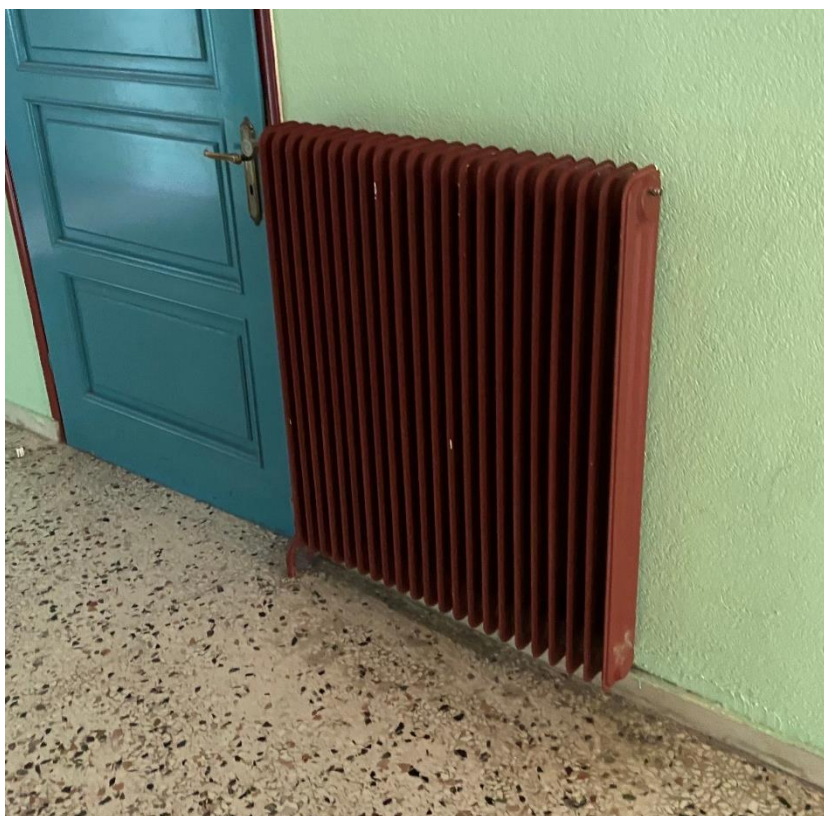
Εικόνα 12: Τυπική τερματική μονάδα
