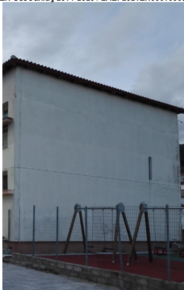
Εικόνα 5: Βορειοανατολική όψη του κτιρίου
