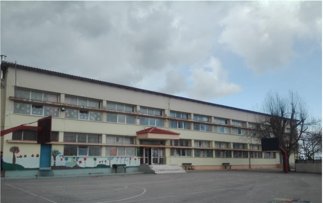
Εικόνα 3: Νοτιοανατολική όψη & πρόσοψη του κτιρίου (κεντρική είσοδος)
