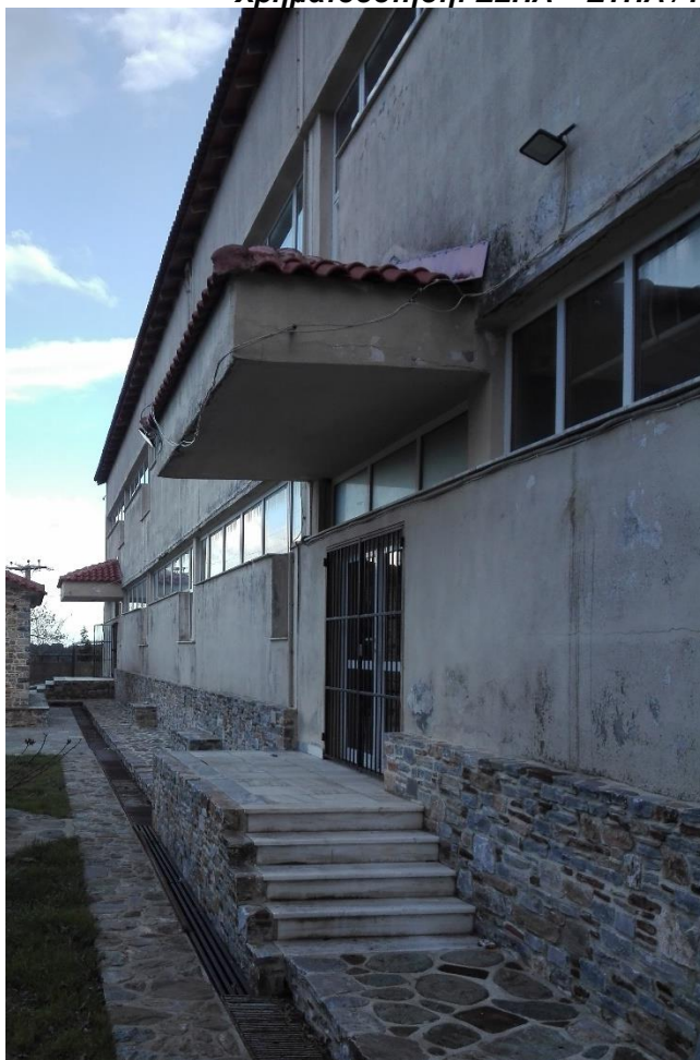
Εικόνα 4: Βορειοδυτική όψη του κτιρίου
