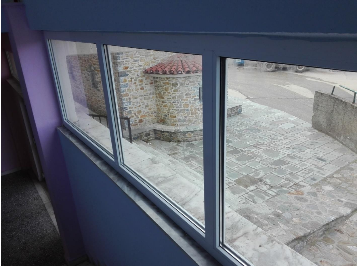
Εικόνα 7: Τυπικά κουφώματα του σχολικού κτιρίου.
