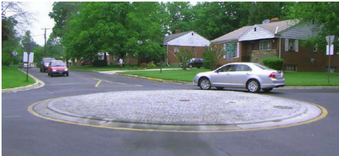
Εικόνα 1 : Κομβίδιο κυκλικής κίνησης (προτείνεται κεντρική υπερύψωση μέχρι 12,5 cm max.)
